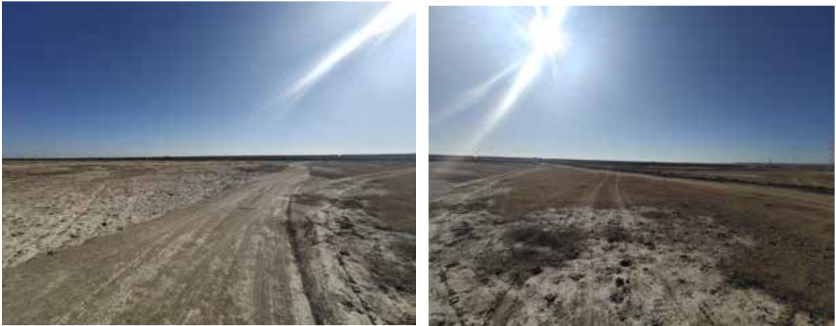
图5 施工道路恢复
