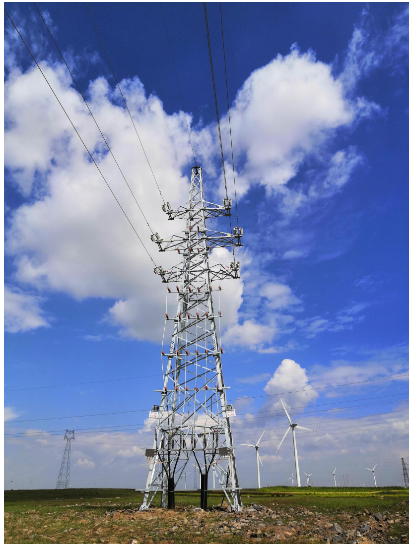
集电线路塔基
