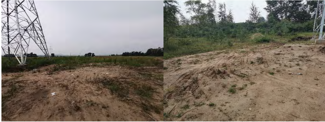
图 1-4 施工生产区现状
