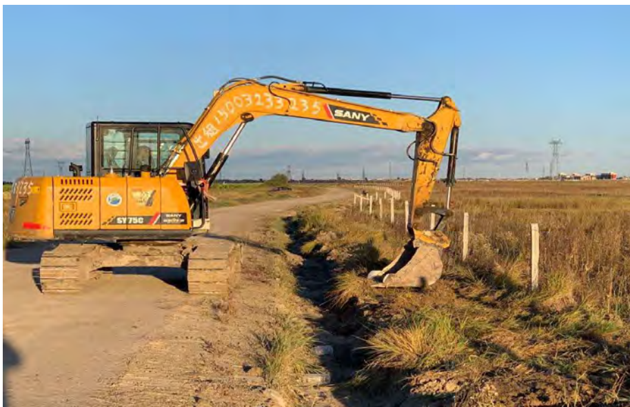
进站道路土质排水沟开挖 2010 年 5 月
