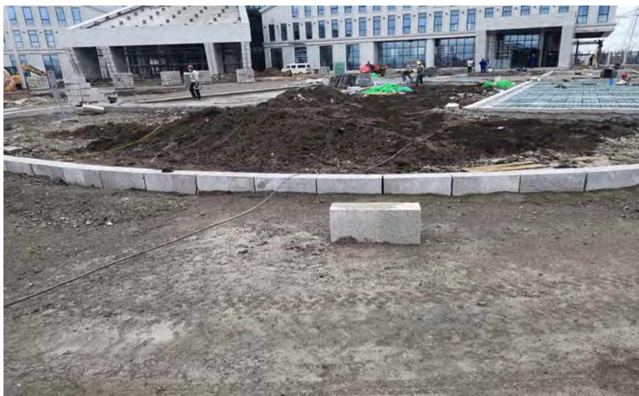
汇集站施工区场地种植土平整 2010 年 7 月
