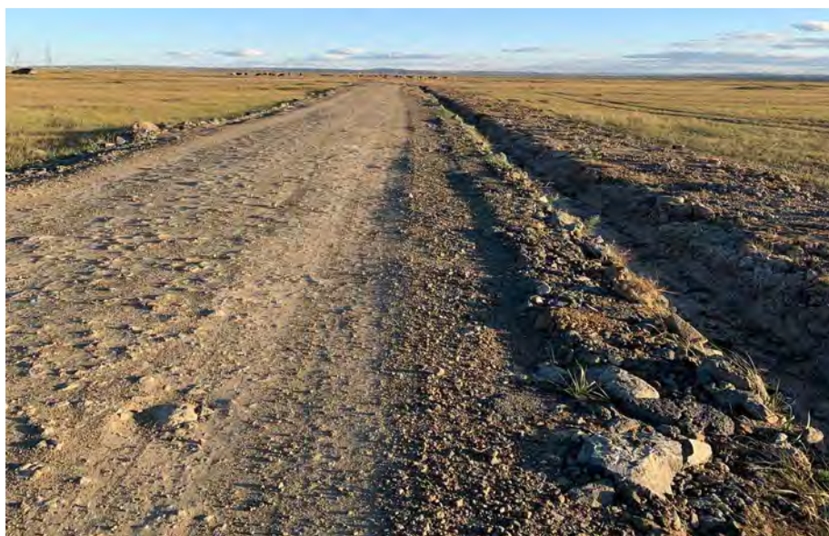
进站道路土质排水沟 2010 年 6 月
