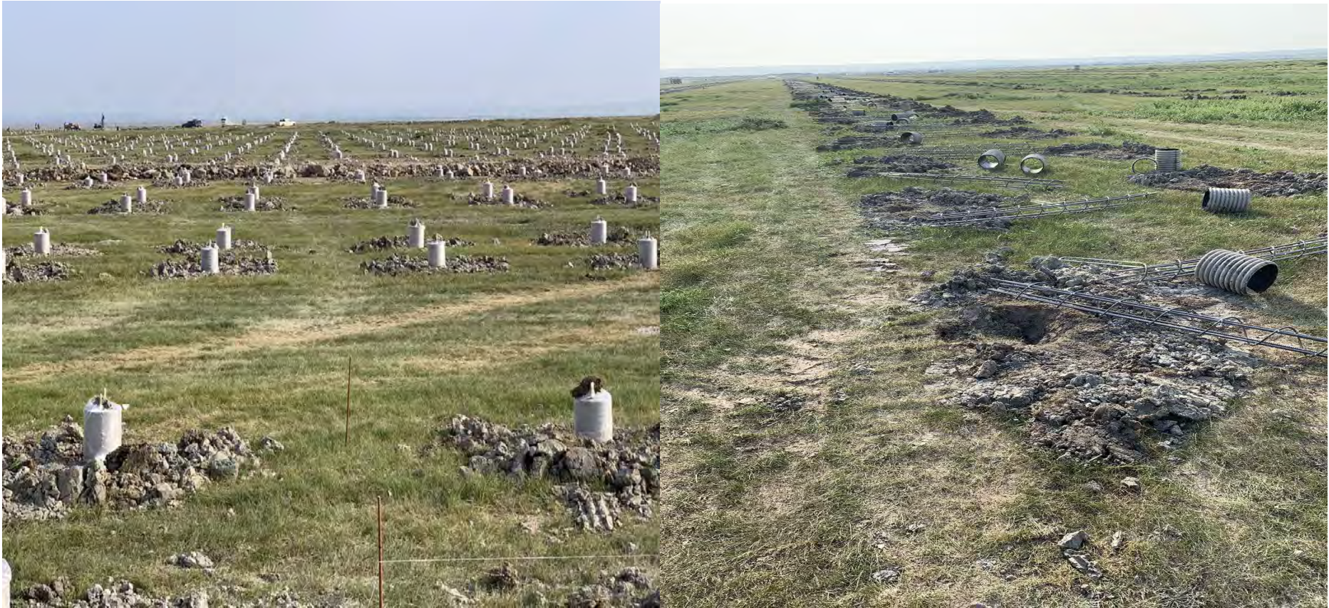
光伏区支座施工 2019 年 9 月
