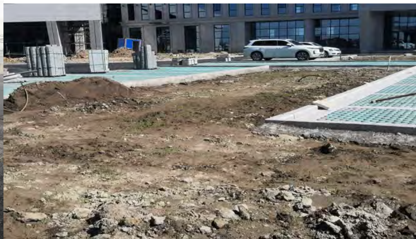
汇集站施工区场地植草砖铺装 2010 年 7 月
