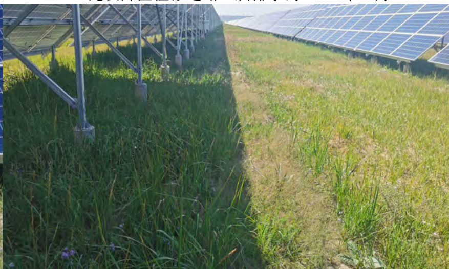
光伏阵区施工后植被恢复 2010 年 8 月
