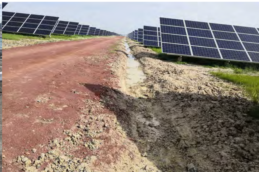
光伏阵区检修道路土质排水沟 2010 年 6 月
