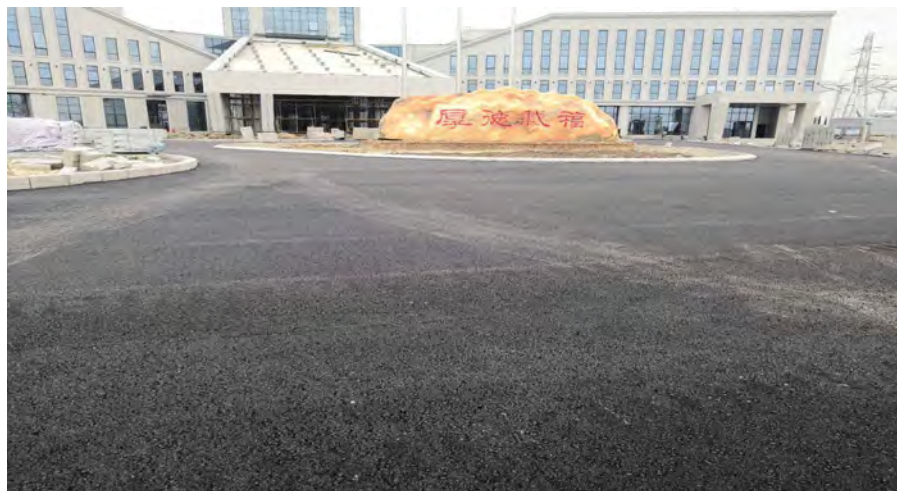
汇集站施工区场地硬化 2010 年 8 月
