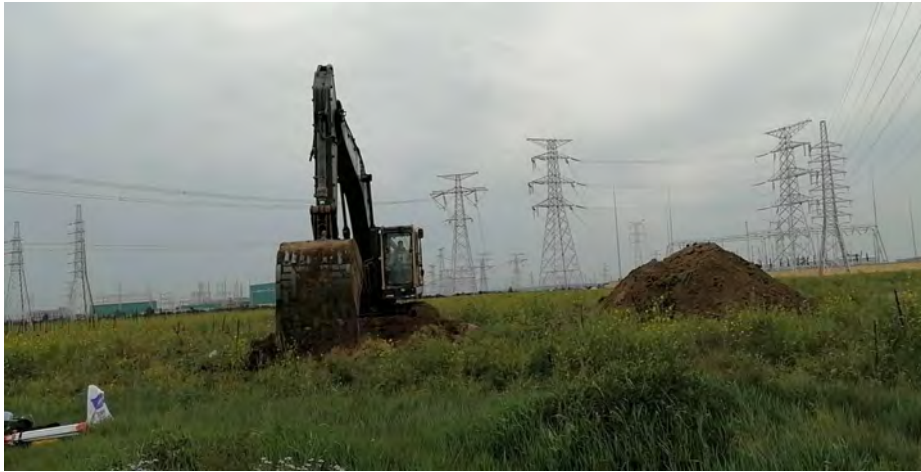
光伏阵区表土开挖 2019 年 7 月
