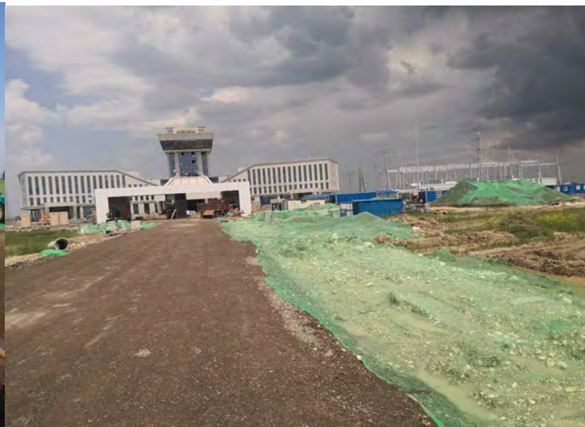
汇集站进站道路区域裸露土石方苫盖 2010 年 5 月
