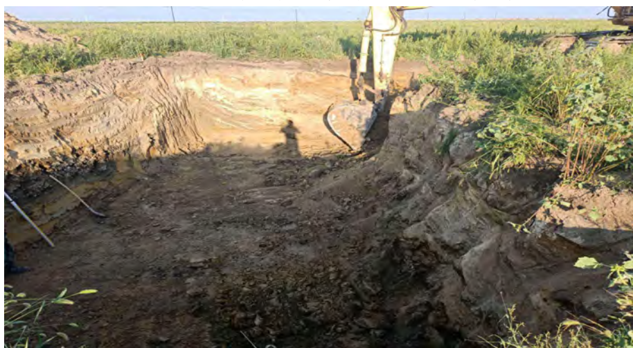
生活区临时沉淀池开挖 2019 年 9 月
