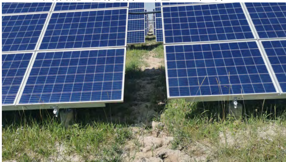
光伏阵区检电缆沟加回填植被恢复 2010 年 9 月
