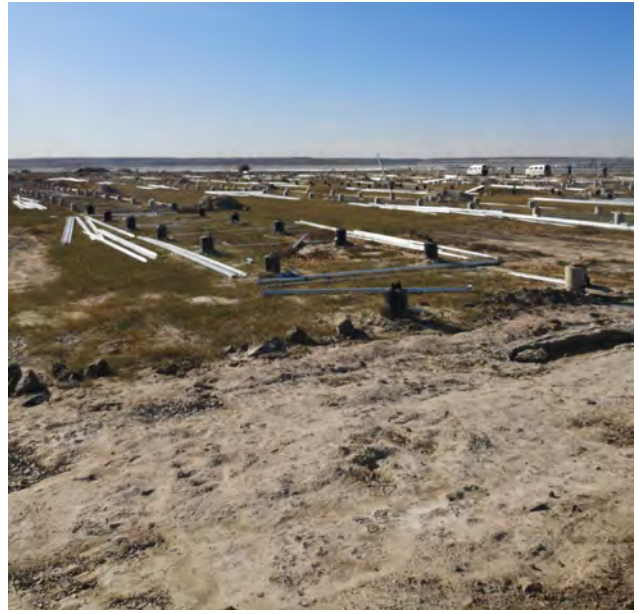
桩基础施工 2019.8
