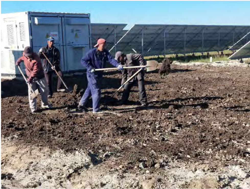
箱变基础周围整地 2020.9.
