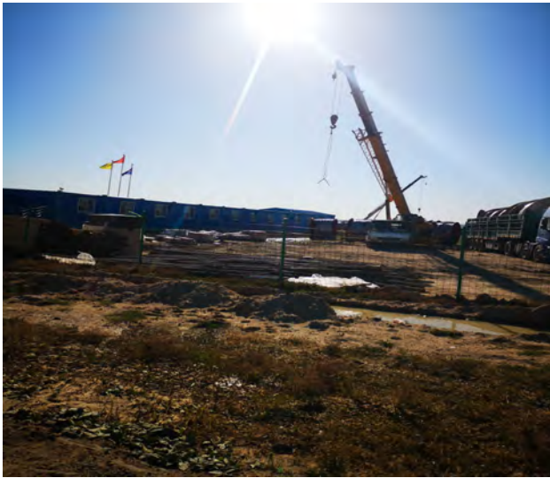
施工生产生活区 2019.8
