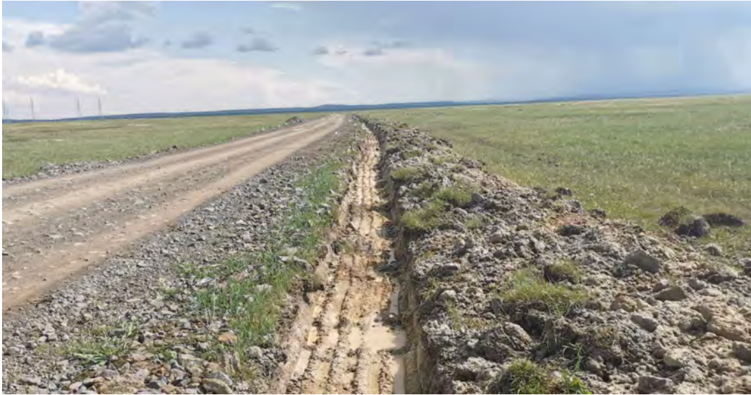
进光伏区道土质排水沟施工 2020.8
