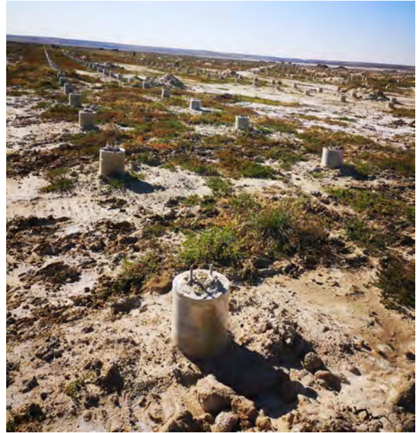
桩基础施工 2019.8
