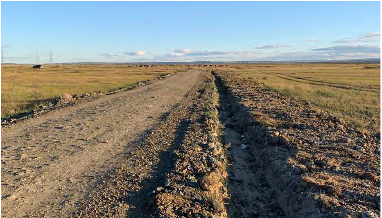
进光伏区道土质排水沟效果 2020.9
