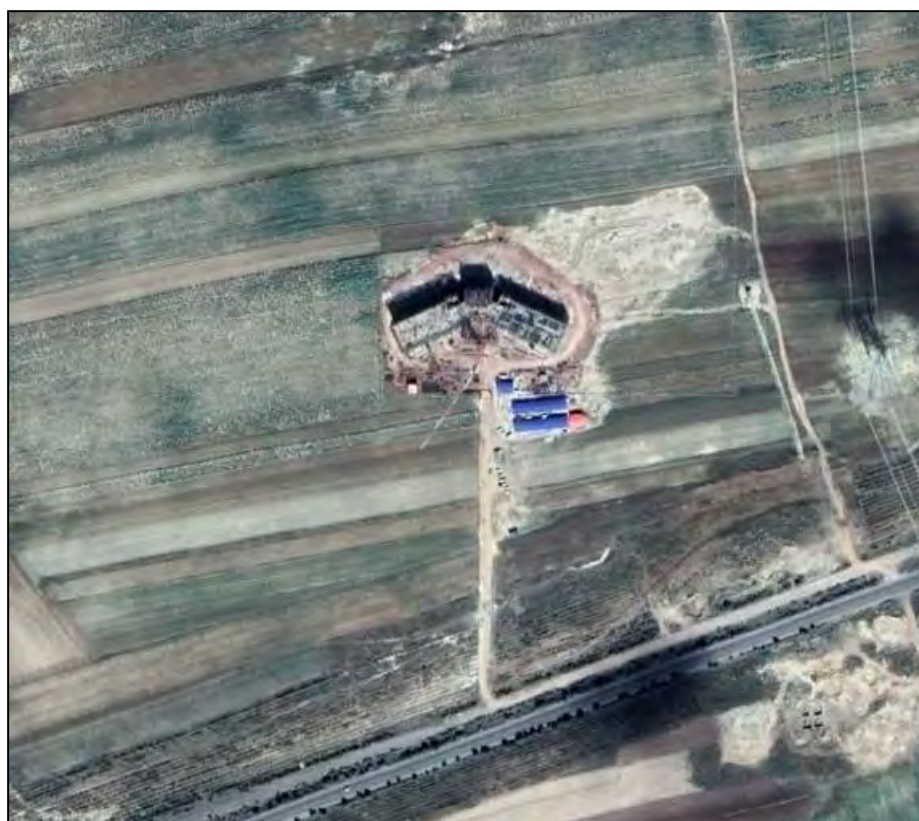
汇集站施工之后项目位置卫星图片 2019.8
