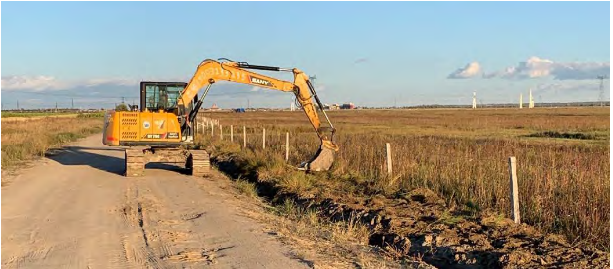
进光伏区道土质排水沟施工 2020.8
