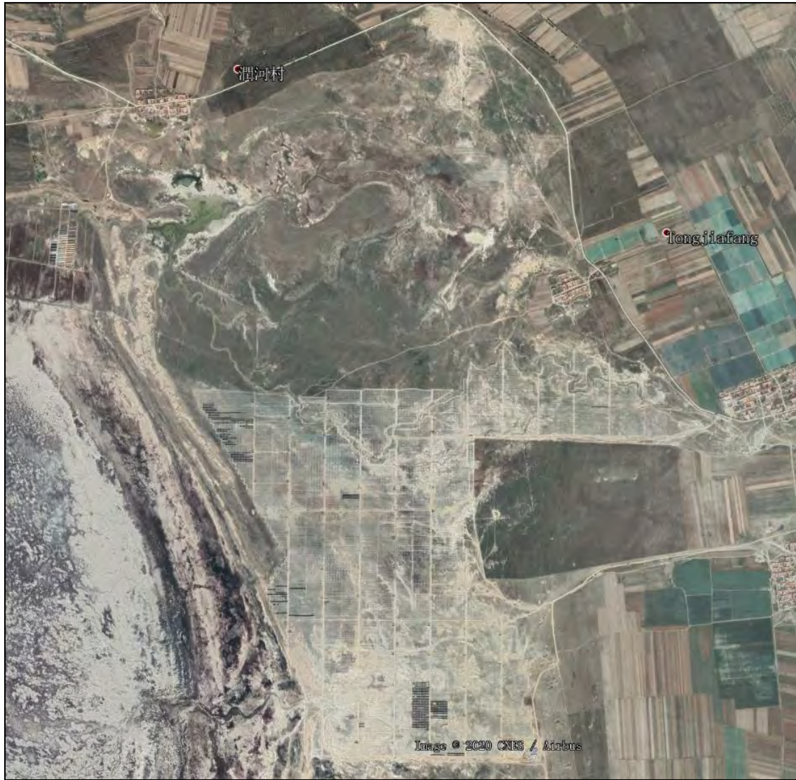
光伏区管桩基础施工之后卫星图片 2019.8
