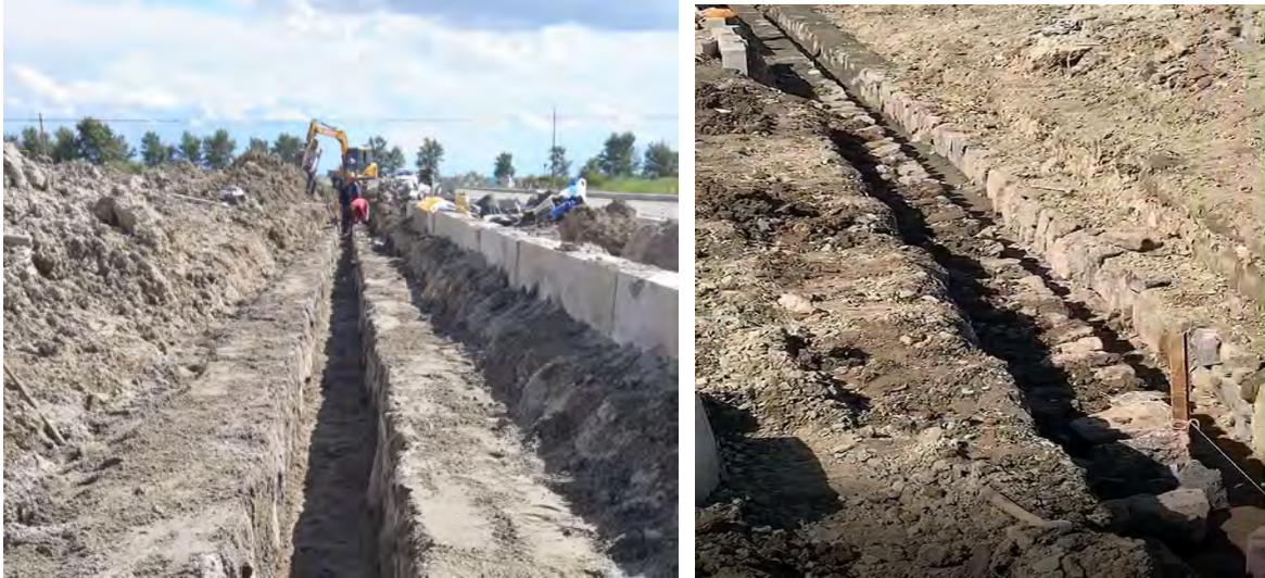
进汇集站道路浆砌石排水沟施工 2020.8
