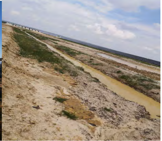
施工生产生活区临时排水沟 2020.6
