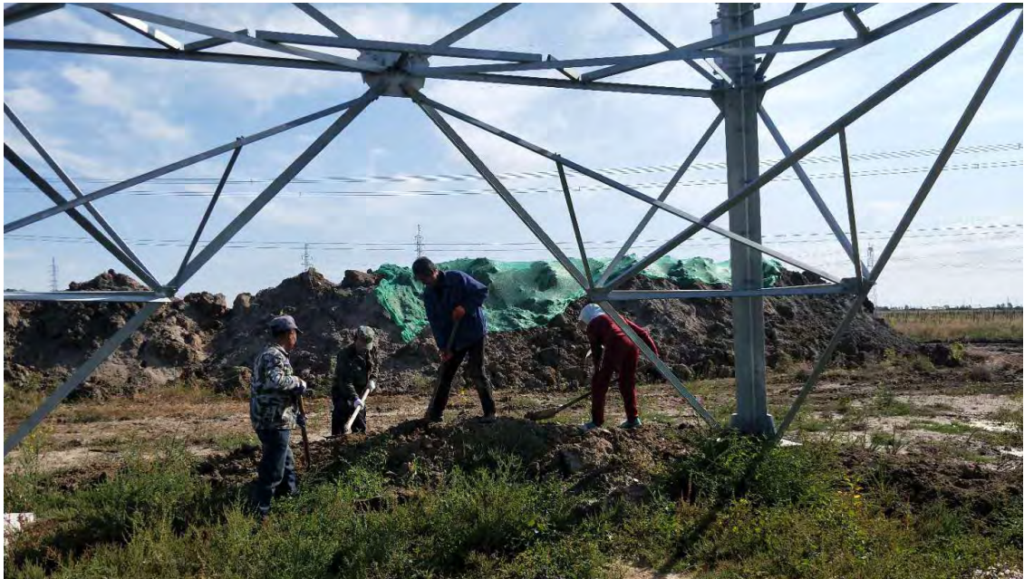
架空线路扰动区域整地 2020.9
