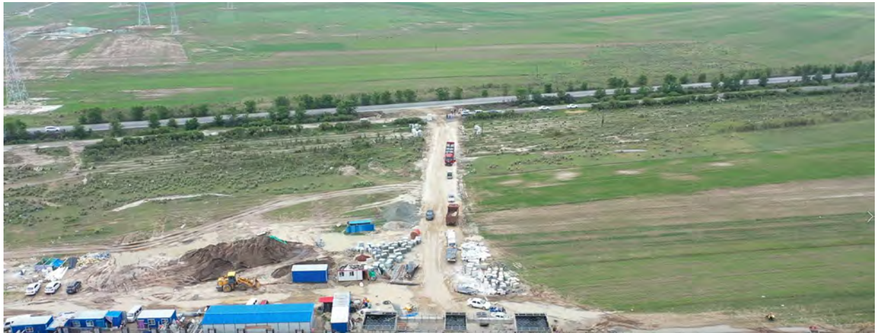
进汇集站道路 2020.6
