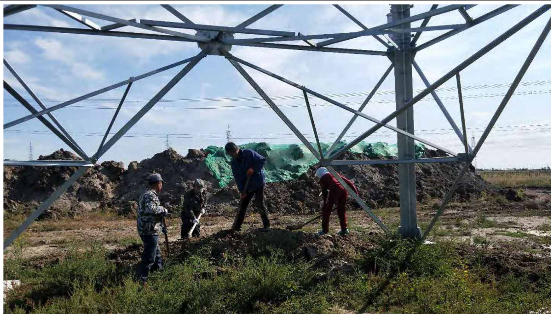
架空线路扰动区域整地 2020.9
