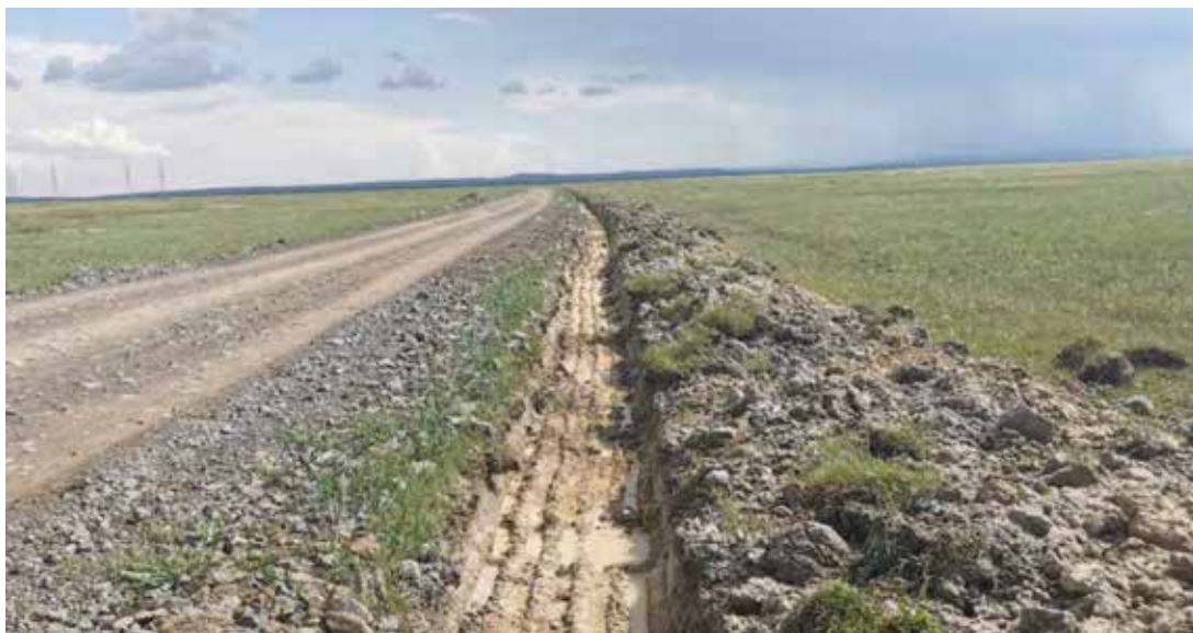
进光伏区道土质排水沟施工 2020.8
