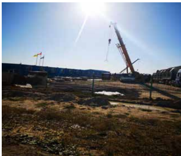
施工生产生活区 2019.8
