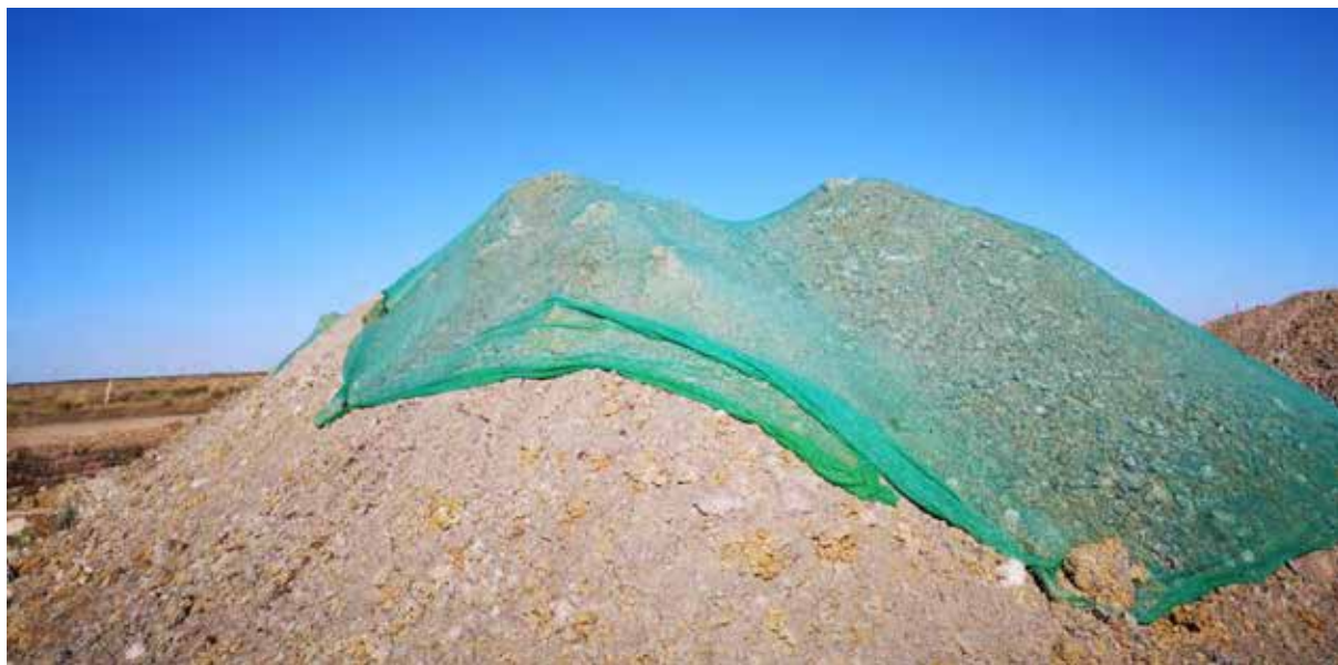
临时堆土苫盖 2019.9
