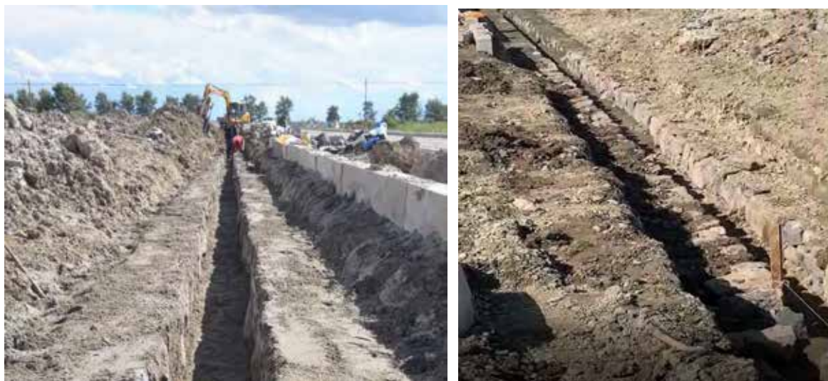
进汇集站道路浆砌石排水沟施工
