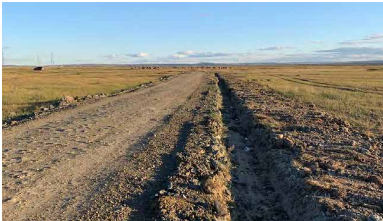
进光伏区道土质排水沟效果 2020.9
