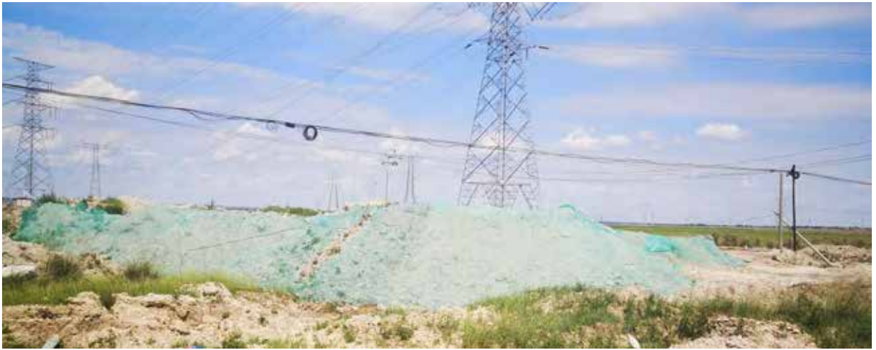
临时堆土遮盖 2020.6
