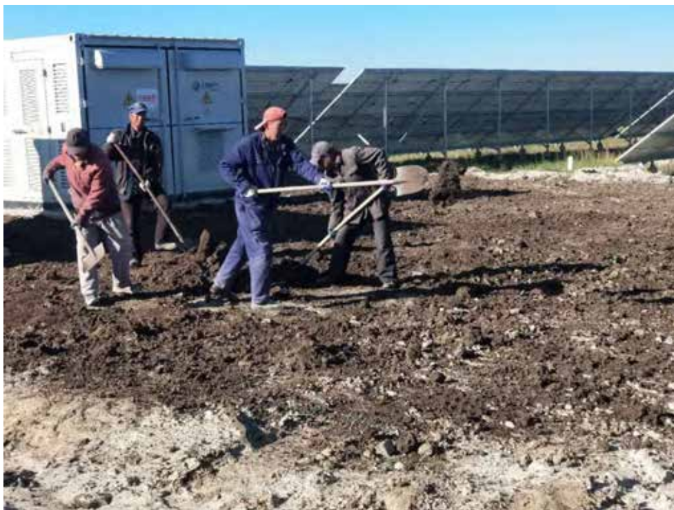
箱变基础周围整地 2020.9.
