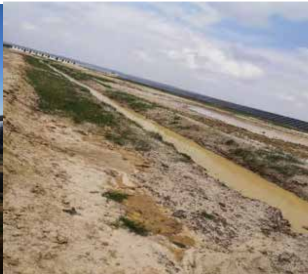
施工生产生活区临时排水沟 2020.6
