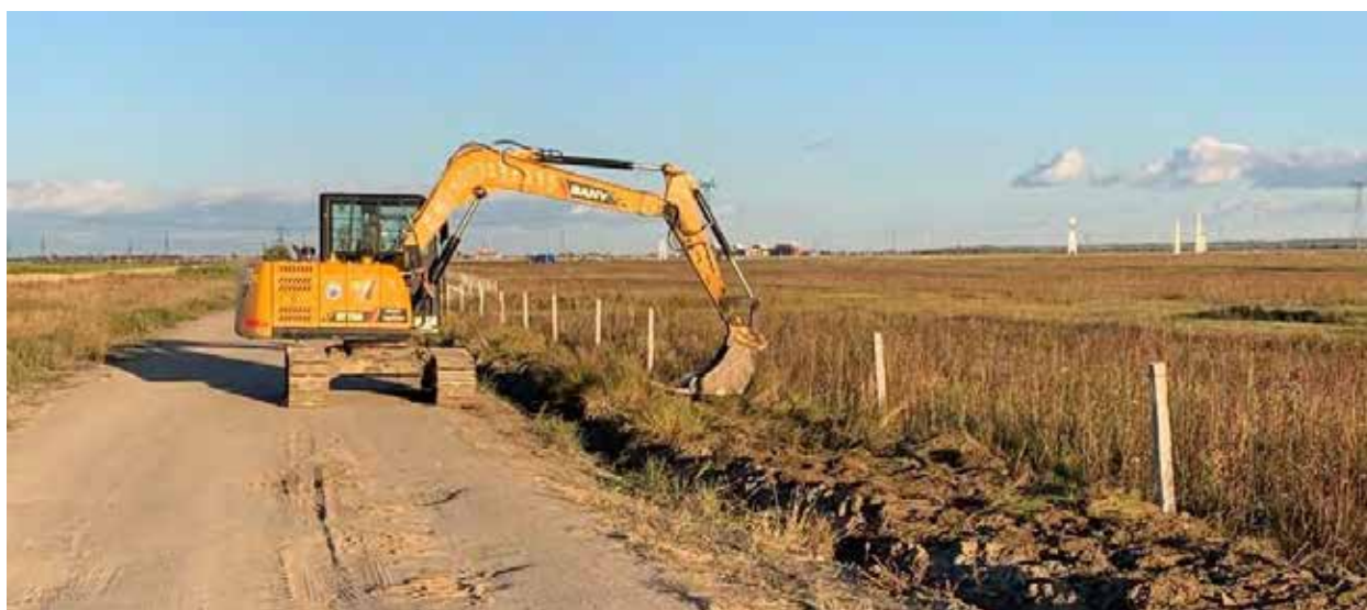
进光伏区道土质排水沟施工 2020.8
